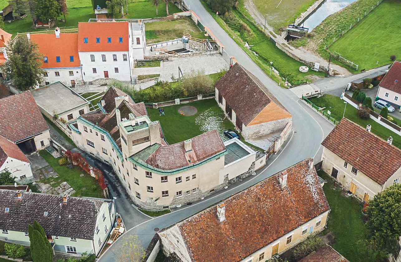
Die Villa wurde minutiös in die engen Gassen des kleinen Dorfes eingepasst.
